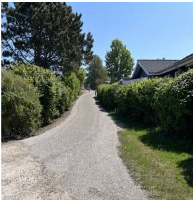
Overfladebelægning på vejen ved nr. 23 udført i 2023
