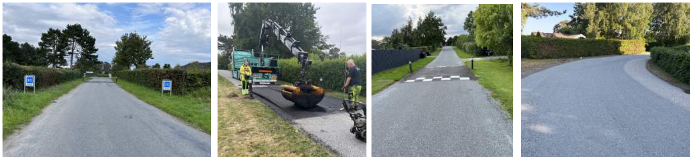
Tiltag i 2023 for at forbedre trafikikkerheden i To-Bjerg. 30 km/t zoneskilte ved indkørslen til To-Bjerg med tilhørende fartdæmpende asfaltbump. Oprettning af sving.
