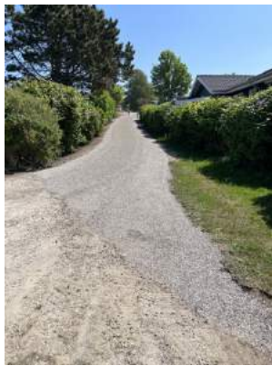
2023: Bakken ved nr. 23 efter renovering
