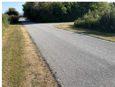
Asfaltveje med ny overfladebelægning
