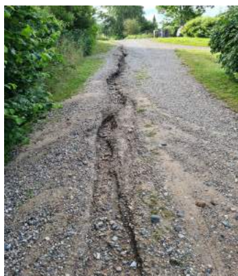
2022: Bakken ved nr. 23 inden renovering
