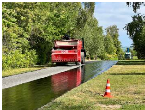
Juni 2023, ny overfladebelægning under udførelse
