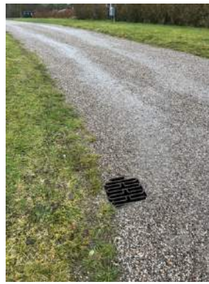
2023: Bakken ved nr. 16 efter renovering. Overfladevandet kan nu løbe til afløbet uden at trække gruset med, som tidligere har fyldt drænet op.
