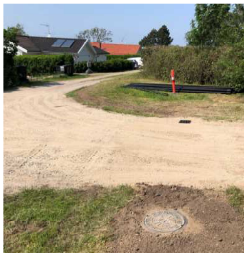
Reovering af vej og dræn ved nr.9
